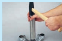
6. Neues Kegelrollenlager mit passendem Rohr auftreiben.
