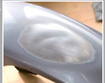
Beule- und Roststelle weiträumig ausschleifen...
